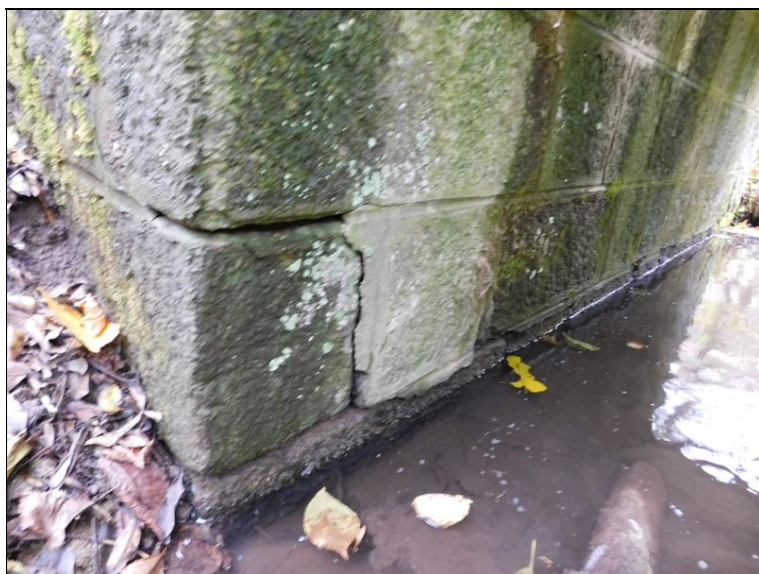
Uvolněný kámen v patě dříku opěry OP2
