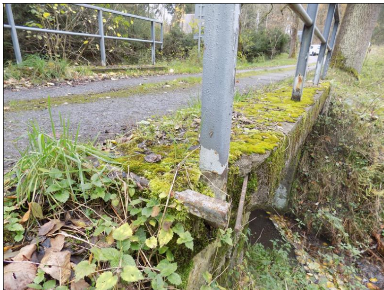
Uvolněný sloupek v pravé římse nad opěrou OP1
