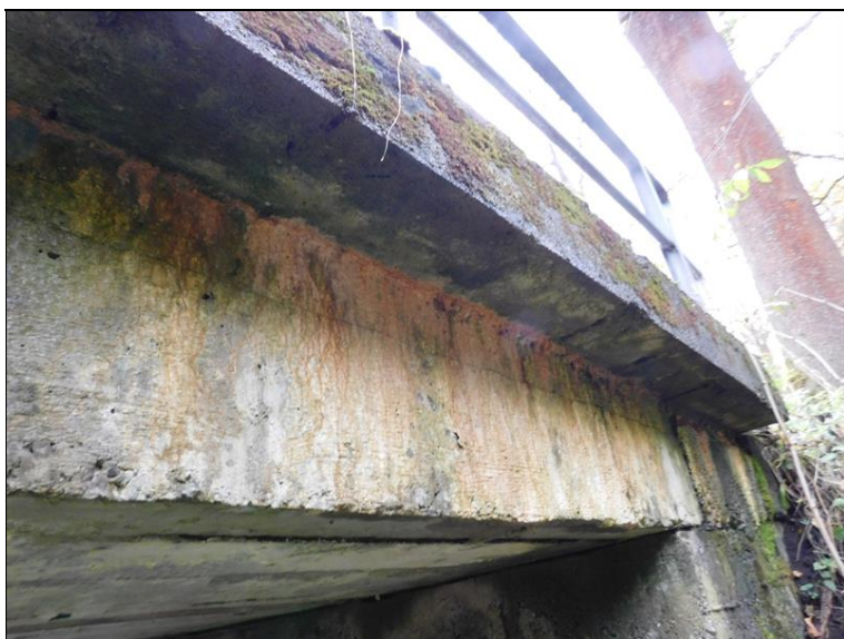
Zatékání pod levou římsou
